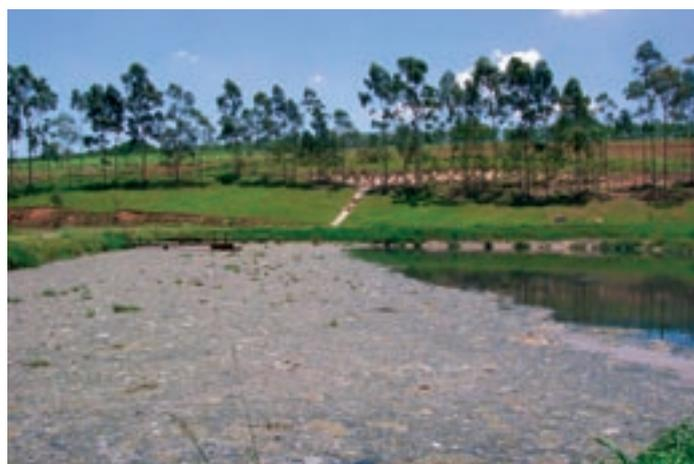
**Bild 2:** Blick auf eine dezentrale Kläranlage mit einem naturnahen Verfahren. Nachteile insbesondere für urbane Strukturen sind der große Platzbedarf der Teichkläranlage und die zeitweise Geruchsbelästigung aufgrund von Überlastung.
