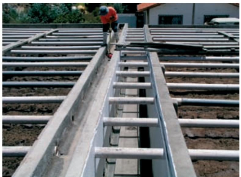
**Bild 4:** Einfache Biofilter-Anlage für die Reinigung von Abwasser aus einer Wurstfabrik.
