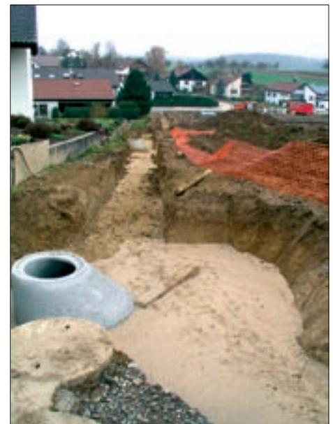
**Bild 2:** Im Rahmen der Erschließungsarbeiten wird die Abwasser-Infrastruktur im Neubaugebiet errichtet.
