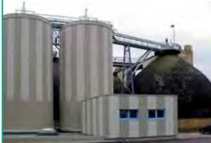
um eine Hochlaststufe, um die Wirtschaftlichkeit der Klärschlammensorgung zu erhöhen, ohne die bisherige Entsorgungslinie außer Kraft zu setzen. Ein Jahr später zeigt sich, dass das Klärwerk auf wesentlich kleinerem Raum sehr viel schneller und effektiver den Klärschlamm zu Biogas umsetzt als zuvor.
