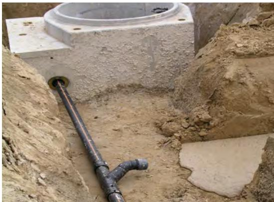
**Vakuuleitungen haben geringere Querschnitte als herkömmliche Abwasserrohre und müssen nicht so tief verlegt werden. (© Fraunhofer IGB) | Bild in Farbe und Druckqualität: [www.igb.fraunhofer.de/presse](http://www.igb.fraunhofer.de/presse)**
